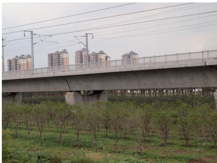
Prefabrykowane estakady Szanghaj – Nankin
