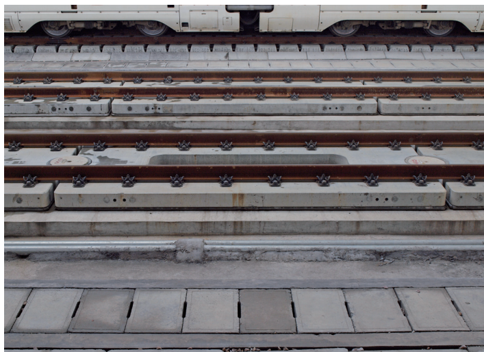
Nawierzchnia bezстыkowa bazująca na rozwiązaniu japońskim
