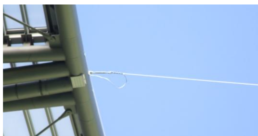
Rys. 6. Konstrukcja zwodu poziomego chroniącego teren boiska; widoczny jeden z trzech zwodów poziomych przymocowany do rury łączącej dźwigary [fot. D. Kowalak]
