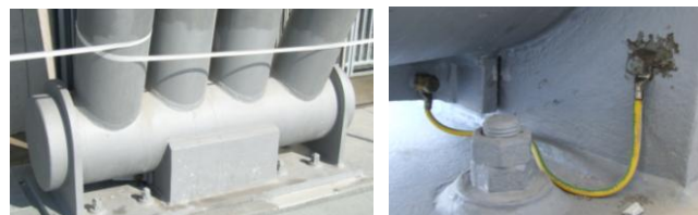
Rys. 8. Widok przegubu łączącego dźwigar zadaszenia z systemem uziemieniowym stadionu, widoczny mostek zwierający elektrycznie części ruchome [fot. D. Kowalak]
