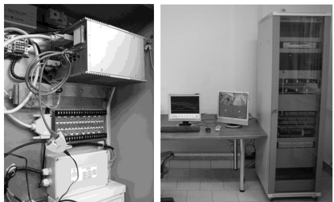
Rys. 9. Wyposażenie stanowiska: a) szafa z komputerem pomiarowym i interfejsami; b) centralne stanowisko diagnostyczne
