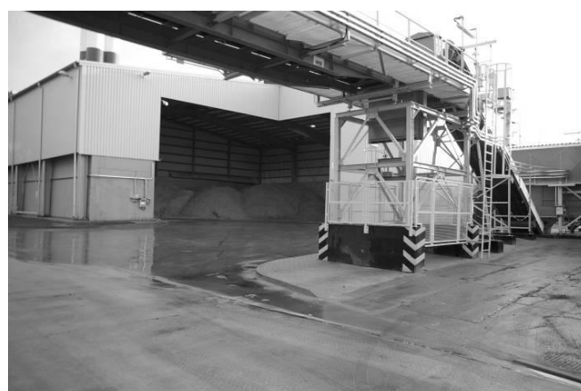
Rys. 5. Magazyn biomasy w Elektrociepłowni Gdyńskiej
