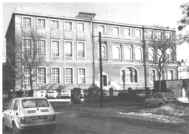
Rys.2. Katedra Wysokich Napięć i Przyrządów Rozdzielczych po przebudowie zaprojektowanej przez prof. Szpora: dobudowano 2. piętro i lewą część budynku (fot. Wiśniewski)
