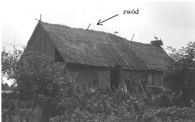
Rys. 4. Piorunochron lekki z drutu stalowego na wspornikach drewnianych na stodole krytej słomą (fot. Wiśniewski)
