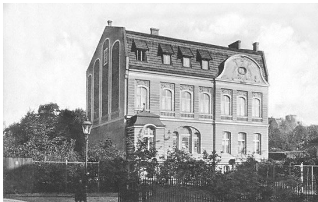
Rys. 1. Przedwojenny budynek loży masonskiej przeznaczony dla Katedry Wysokich Napięć i Przyrządów Rozdzielczych prof. Szpora.
