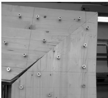
Rys. 17. Wzmocnienie elementu drewnianego wkrętami stalowymi [5]
