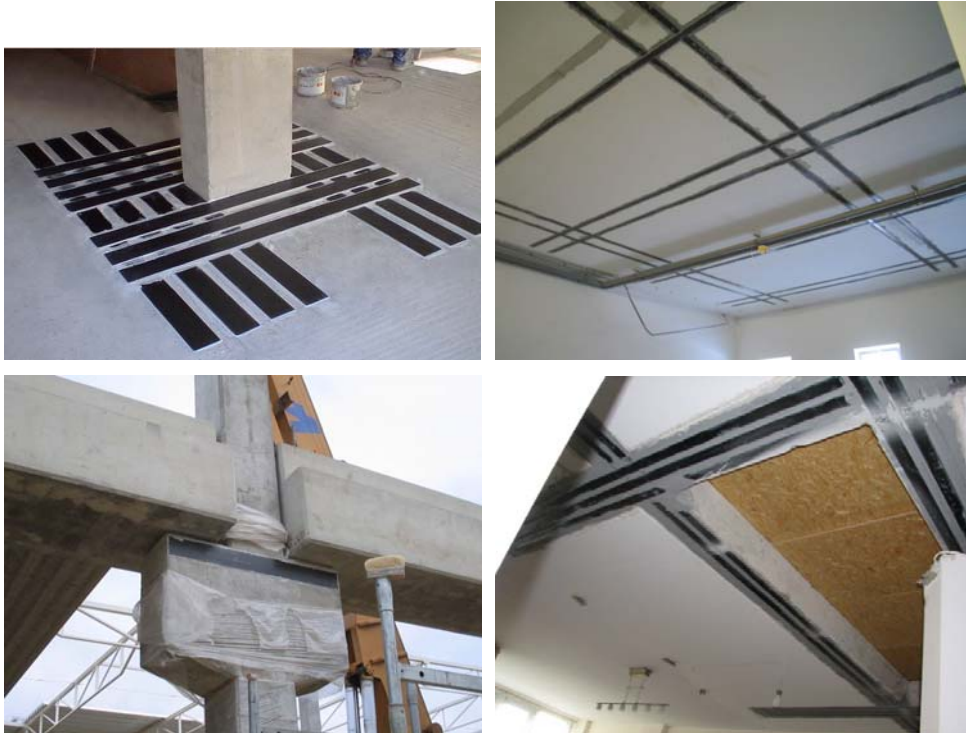
Rys. 4. Przykłady konstrukcji wzmacnianych taśmami węglowymi [9]
