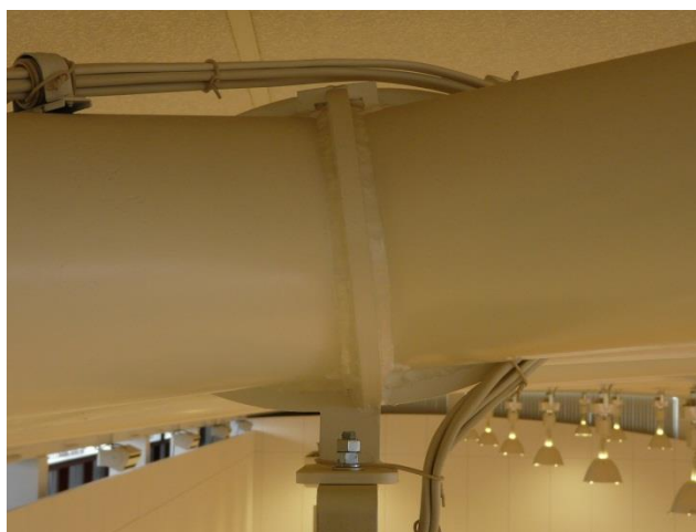
Rys. 13. Węzeł hali AnteLopes (fotografia autora)
