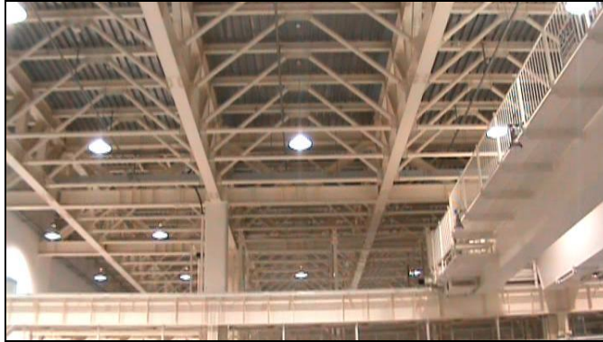
Rys. 14. Konstrukcja Phoenix Laboratory (fotografia autora)
