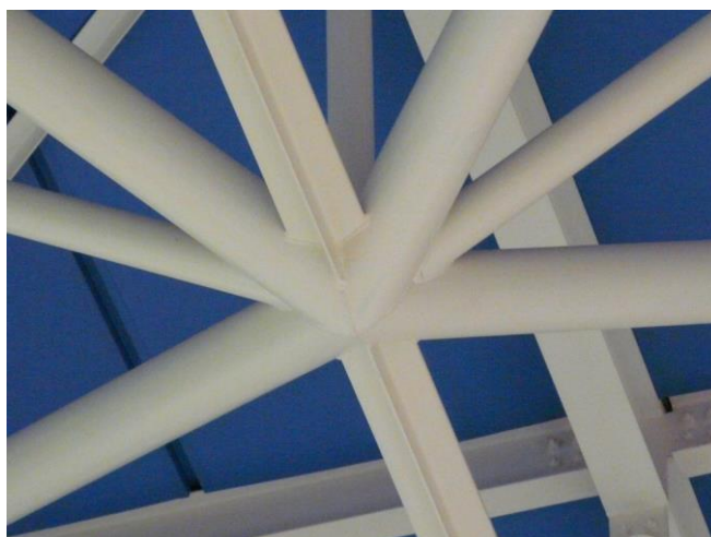
Rys. 1. Węzeł kratownicy przekrycia Mazak World Technology Center, Minokamo (fotografia autora)
