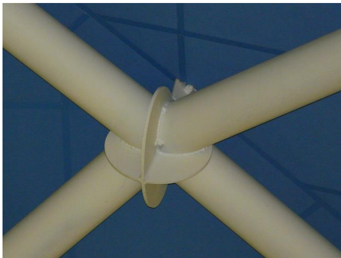
Rys. 8. Węzeł przekrycia Nagashima SPA Dome (fotografia autora)
