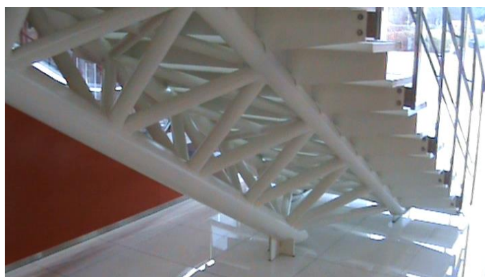
Rys. 5. Fragment konstrukcji schodów w Mazak World Technology Center, Minokamo (fotografia autora)
