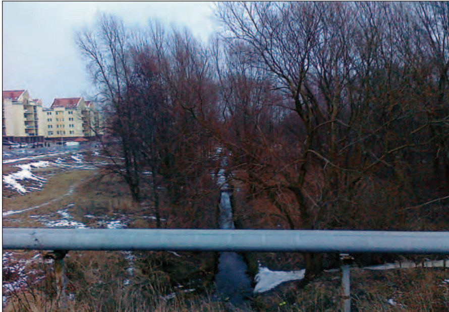
Fot. 1 Rzeka Krępicza poniżej ul. Stańczukowskiego. Budynki nr 28-32 przy ul. Korczak (fot. Z. Staszewski, 2012)
