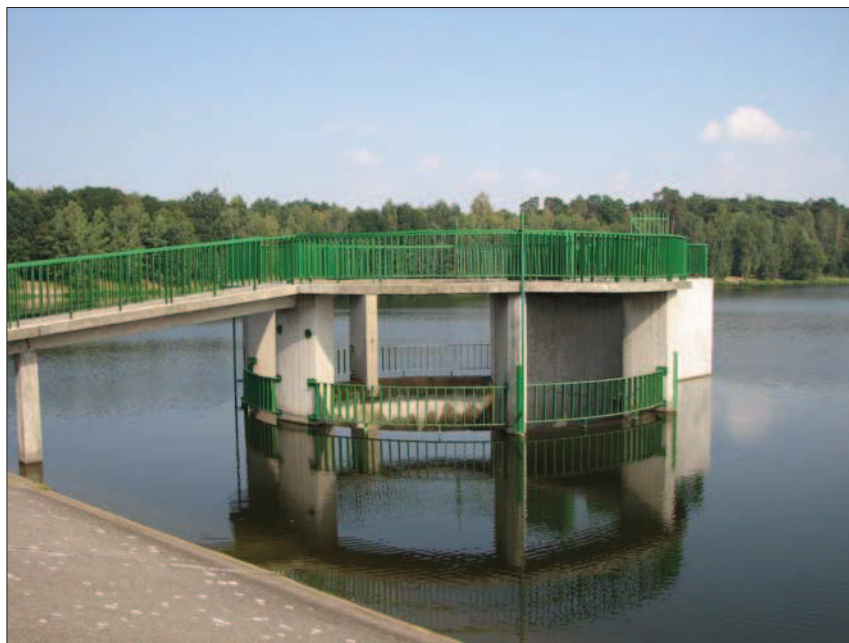
Fot. 3. Wieża upustowa zbiornika Pokrzywnica
