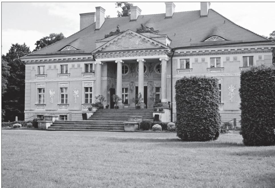
Fot. 1. Pałac Lipskich w Lewkowie – fasada południowa
