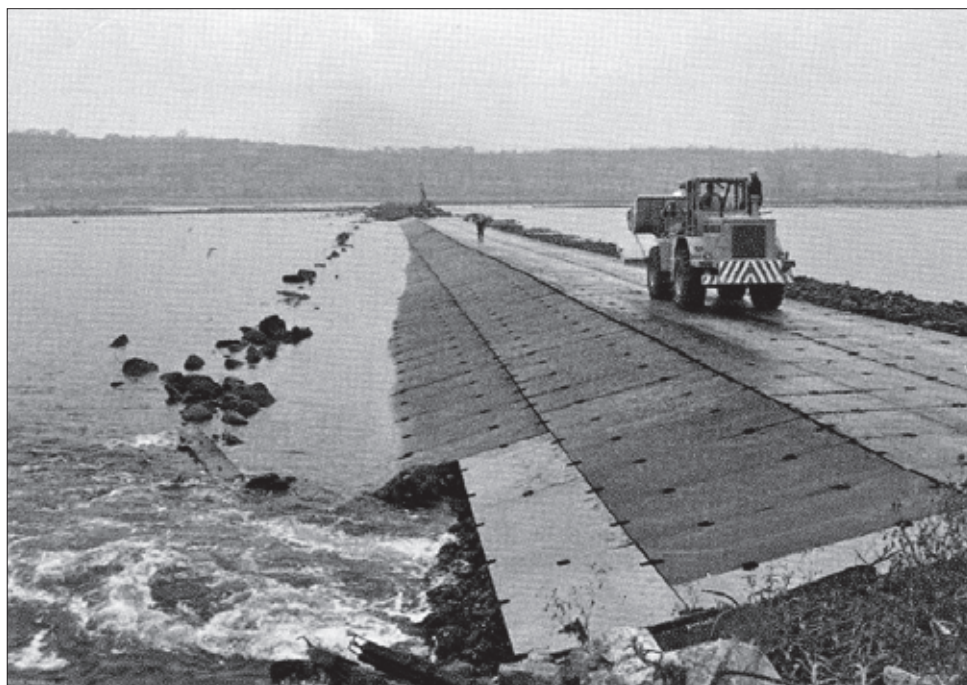
Fot. 1. Próg podpierający stopień wodny we Włocławku
