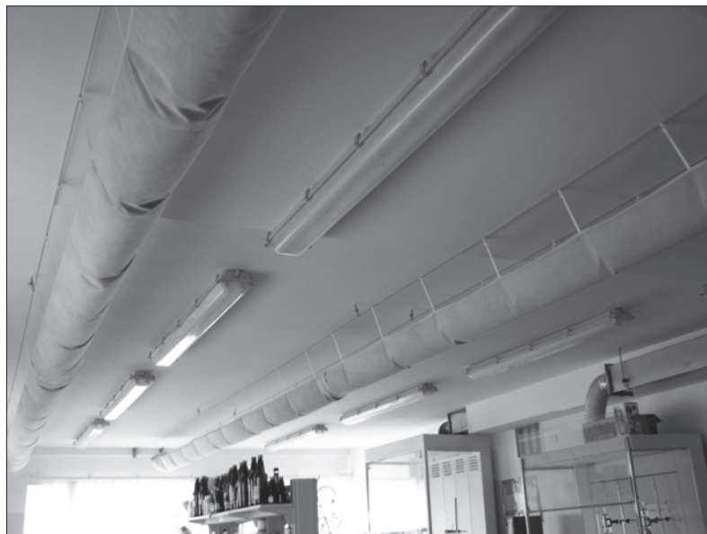
Fot. 2. Przewody wentylacyjne tekstylne (nawiewniki)
