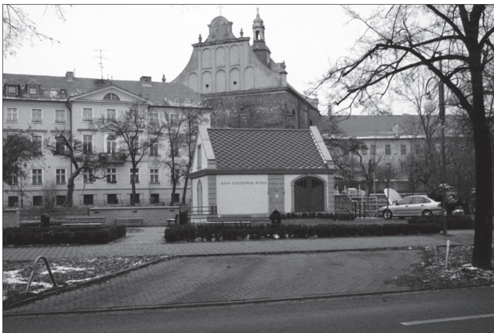
Fot. 13. Mała elektrownia wodna na rzece Prośnie w Kaliszu
