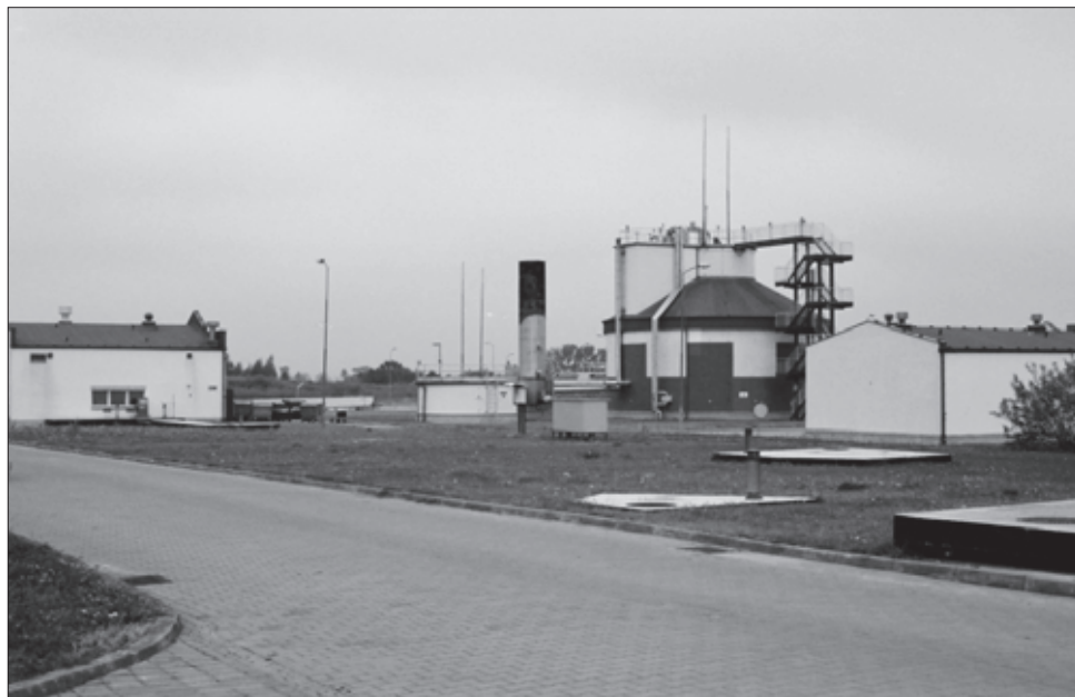
Fot. 6. Grupowa oczyszczalnia ścieków w Kucharach k/Kalisza
