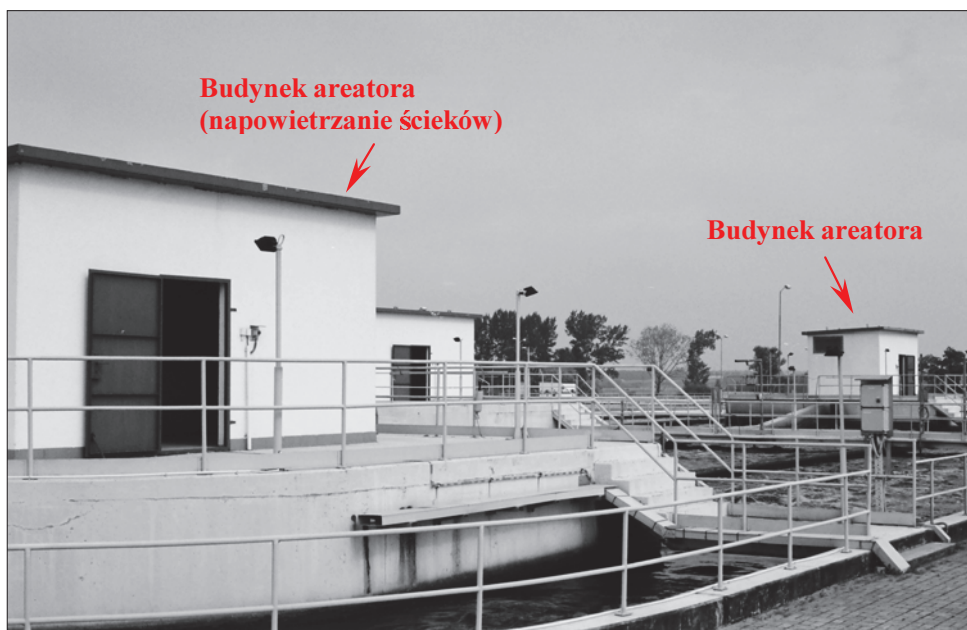
Fot. 17. Grupowa oczyszczalni ścieków w Kucharach k/Kalisza. Budynek aeratora
