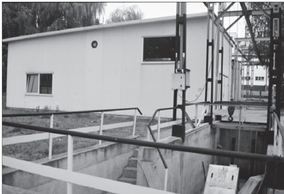
Fot. 10. Podczyszczalnia ścieków i odtłuszczownik w Kaliszu
