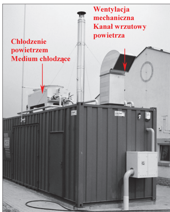
Fot. 19. Grupowa oczyszczalnia ścieków w Kucharach k/Kalisza, kogeneratorski zasilany biogazem (skojarzona gospodarka)
