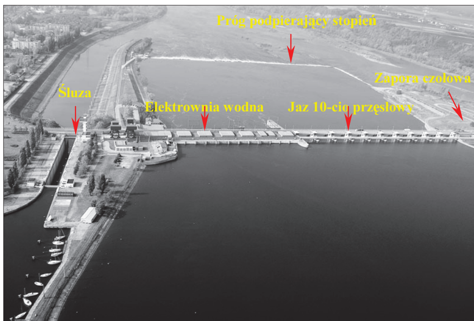
Fot. 15. Elektrownia wodna we Włocławku
