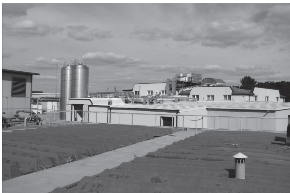
Fot. 11. Oczyszczalnia mechaniczno-biologiczna w Goliszewie k/Kalisza, Mleczarnia „Ceko”
