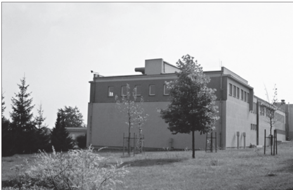
Fot. 12. Ujęcie wody „Lis” ze studni zlokalizowanej wzdłuż rzeki Proсны i stacja uzdatniania wody – Kalisz
