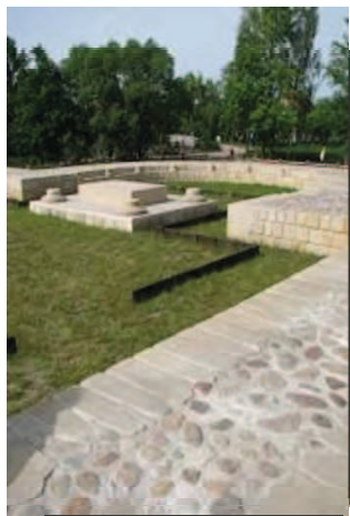
Fot. 1. Fundamenty kościoła
