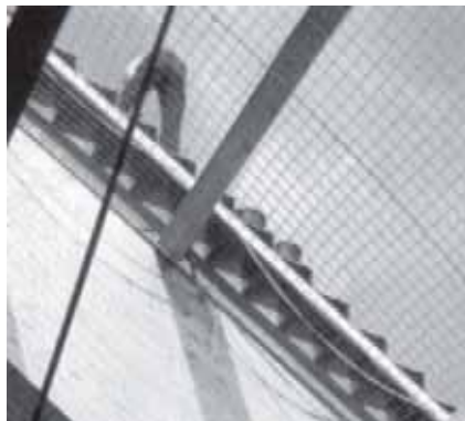
Fot. 7. Przykład wykorzystywania siatki bezpieczeństwa podczas robót na wysokości
