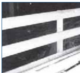
Fot. 5. Balustrada drewniana umieszczona przy krawędzi stropu
