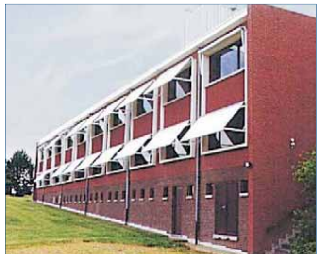
Fot. 1. Widok okien zainstalowanych w budynku PROBE [1]
