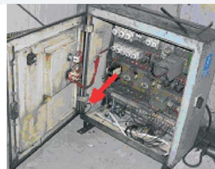
Fot. 3. Przykłady drzwi szaf sterowniczych z doprowadzonym przewodem ochronnym Photo 3. An example of a control-cabinet door with a protective conductor
