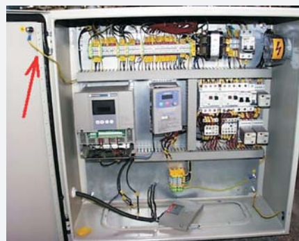
Fot. 3. Przykłady drzwi szaf sterowniczych z doprowadzonym przewodem ochronnym Photo 3. An example of a control-cabinet door with a protective conductor
