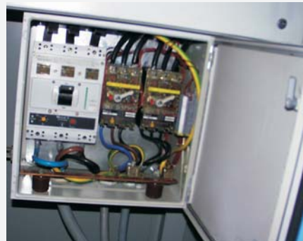
Fot. 2. Przykłady drzwi szafy sterowniczej bez doprowadzonego przewodu ochronnego Photo 2. An example of a control-cabinet door without a protective conductor
