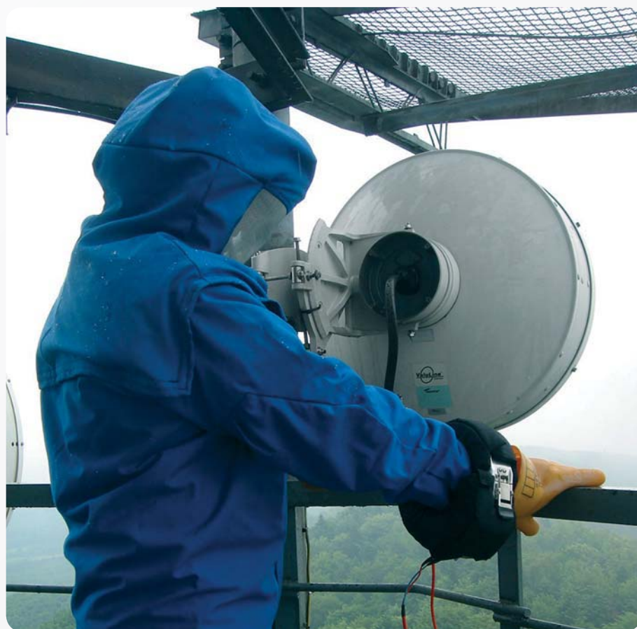
Fot. Jolanta Karpowicz. Ubiór chroniący przed promieniowaniem mikrofalowym, opracowany przez CIOP-PIB
