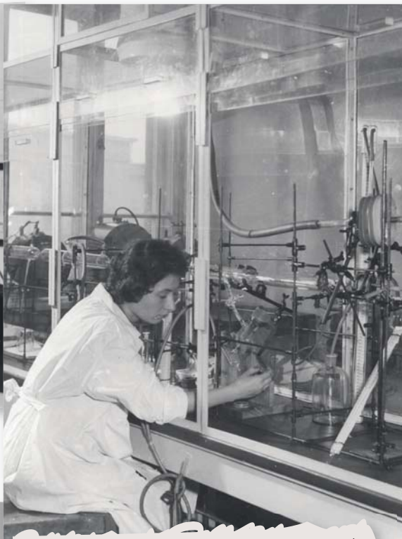
Zakład Radiologii (z czasem wchłonięty przez Zakład Chemii) – stoisko do badania, przy pomocy pyłów radioaktywnych, materiałów o dużej sprawności filtracji. I. Zarzycka. Rok 1962
