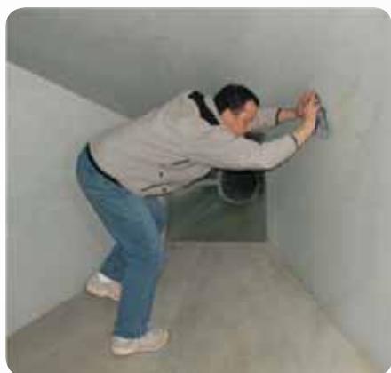
Fot. 4. Wcieranie środka konserwacyjnego w powierzchnię ściany – 1
