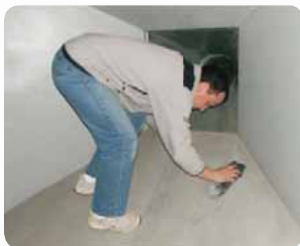
Fot. 2. Wcieranie środka konserwacyjnego w powierzchnię podłogi – 1
