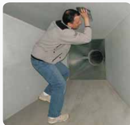
Fot. 6. Wcieranie środka konserwacyjnego w powierzchnię sufitu
