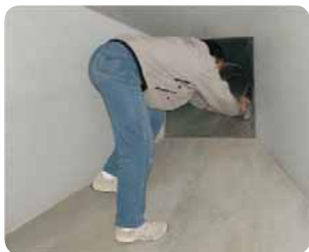
Fot. 1. Czyszczenie środkiem konserwującym w kanale wentylacyjnym
