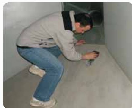
Fot. 3. Wcieranie środka konserwacyjnego w powierzchnię podłogi – 2
