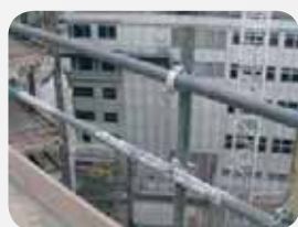
Fot. 6. Balustrada ze stalowymi słupkami, poręczą i poprzeczką
