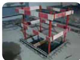
Fot. 13. Zabezpieczenie otworu
