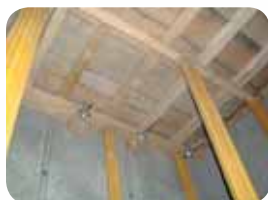
Fot. 11. Tymczasowy podest w szybie windowym
