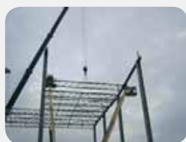
Fot. 7. Montaż konstrukcji stalowej
