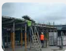
Fot. 8. Montaż szalunku pod konstrukcją żelbetową – metodą „od spodu”
