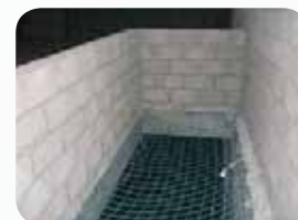
Fot. 14. Siatka bezpieczeństwa na co 2. poziomie
