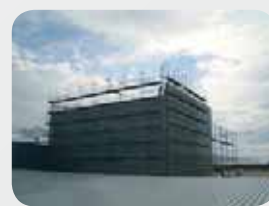
Fot. 10. Rusztowanie elewacyjne
