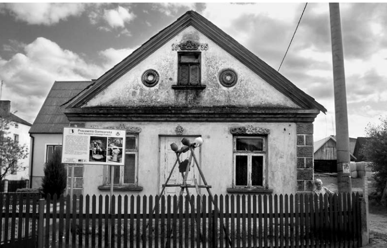
Ryc. 1. Dom w Czarnej Wsi Kościelnej przy ul. Pięknej 29, wzniesiony w 1935 roku, mający ściany z dachówkowych skorup spajanych zaprawą cementowo-wapienną. Fot. Inez Horba, 2012
