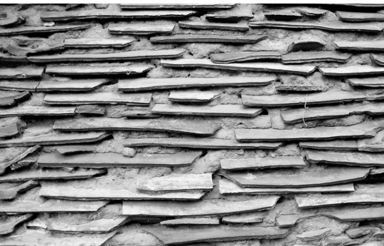
Ryc. 3. Fragment ściany budynku gospodarczego przy jednej z posesji przy ul. Pięknej w Czarnej Wsi Kościelnej, z dachówkowych skorup spajanych gliną. Fot. Inez Horba, 2012
