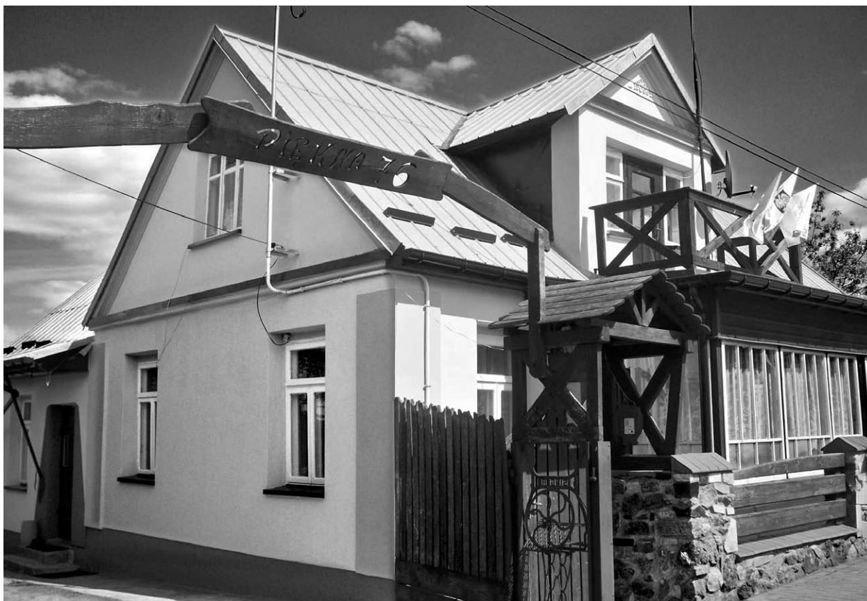
Ryc. 11. Dom w Czarnej Wsi Kościelnej przy ul. Piękną, wzniesiony w 1938 roku, mający otynkowane ściany z dachówkowych skorup spajanych zaprawą cementowo-wapienną. Fot. Inez Horba, 2012
