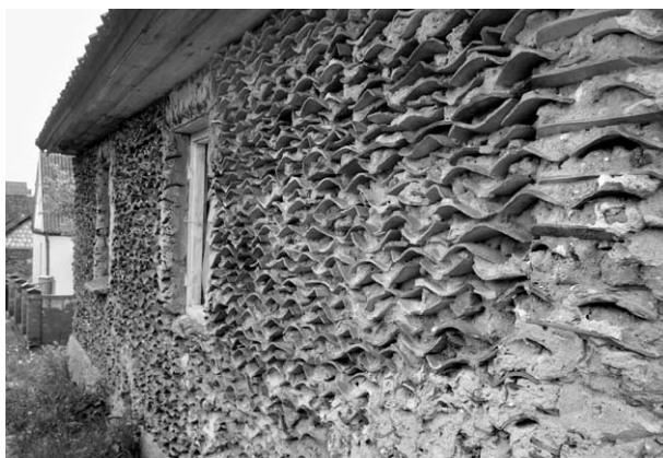
Ryc. 4. Fragment ściany pracowni garncarskiej Stary Młyn w Czarnej Wsi Kościelnej, z dachówkowych skorup spajanych gliną. Fot. Inez Horba, 2012
