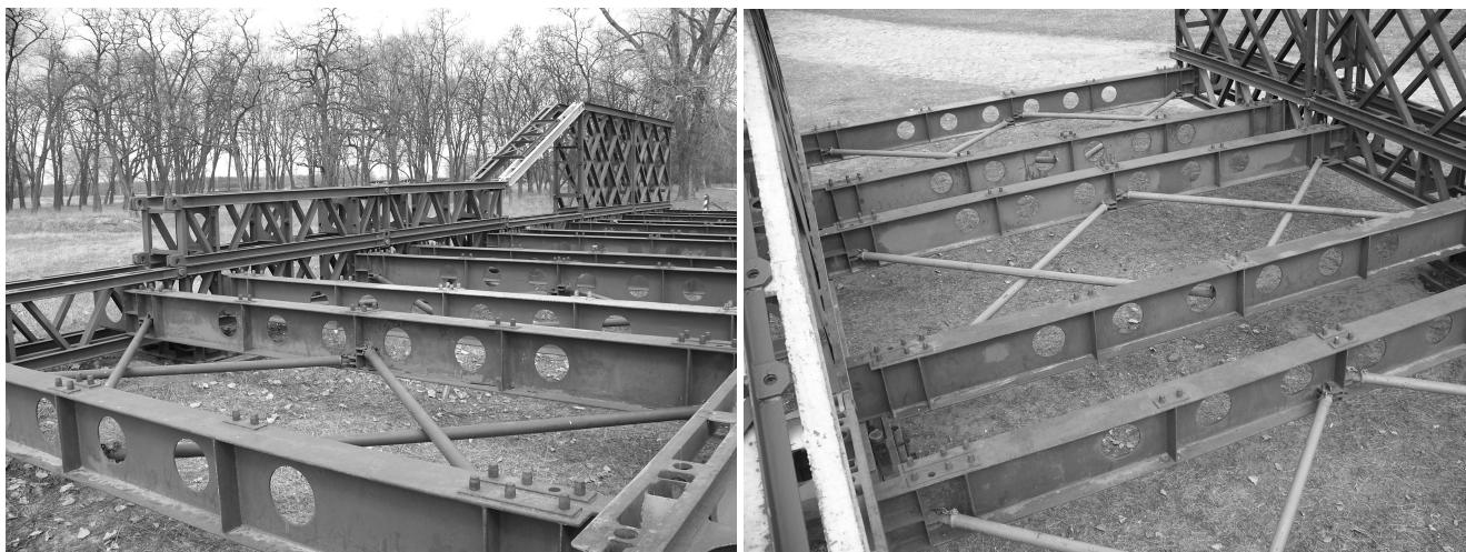
Rys. 1. Widok na most składany typu DMS-65 podczas montażu – połączenie belki poprzecznej z dźwigarami głównymi złożonymi z kratownic przestrzennych (Mondel, 2012)
