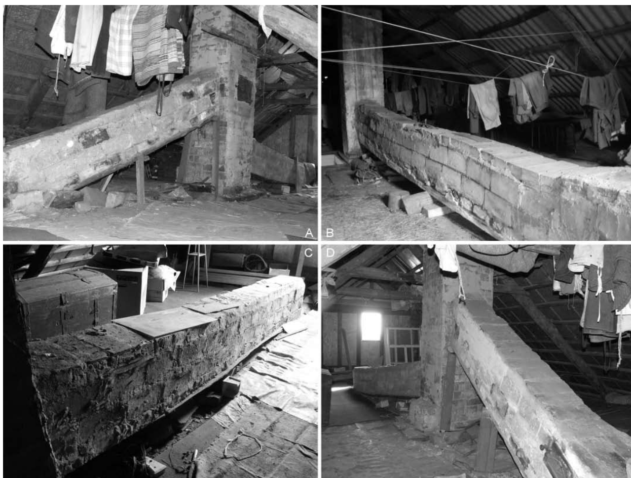
Ryc. 3. Leżaki kominowe i kominy na stropie; A, C i D – Husaki (gm. Bielsk Podlaski); fot. autor, B – Hryniewicze Duże (gm. Bielsk Podlaski); fot. z archiwum ZUiPP WA PB
