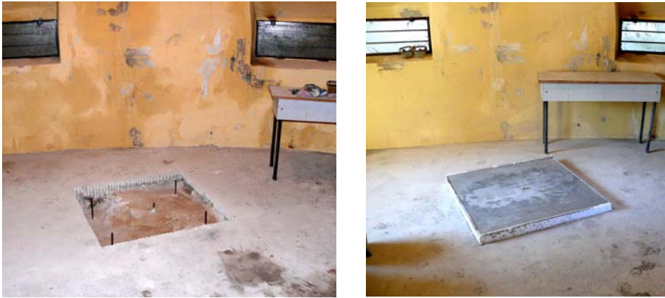
Rys. 6. Etapy stabilizacji punktu G_KAP
