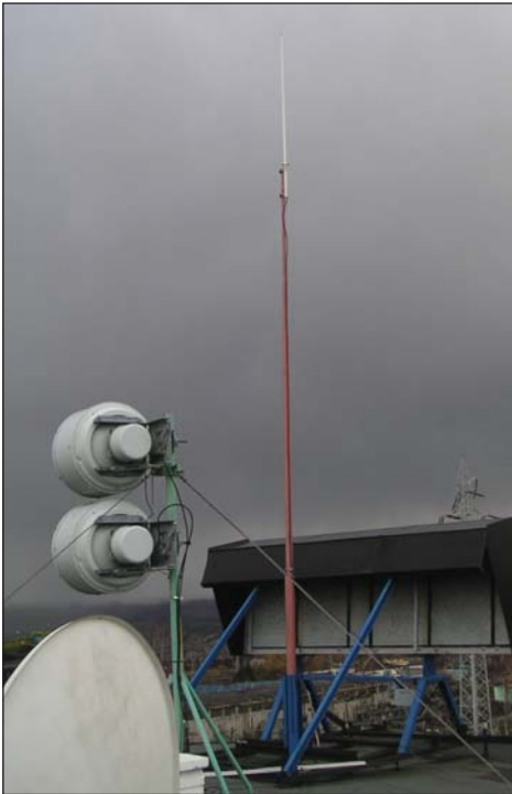
Fot. 4. Antena nadawcza stacji referencyjnej Phot. 4. The broadcasting aerial of the reference station
