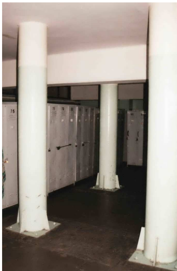
Rys. 3. Słupy stalowo-betonowe o średnicy 407 mm podpierające płytę żelbetową posadowienia maszyn PLANETA
