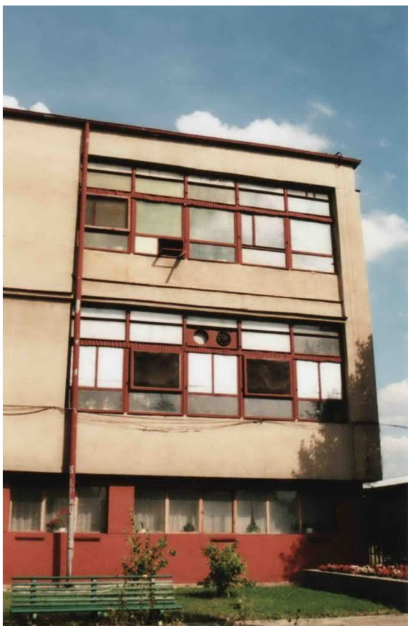
Rys. 1. Ściana szczytowa budynku produkcyjnego, w którym na kondygnacji II planowany był montaż nowej maszyny drukarskiej: a) przed montażem, b) po montażu (transport podzespołów maszyny odbywał się po zdemontowaniu okna i wyburzeniu podokiennej części ściany; – jasny fragment)
