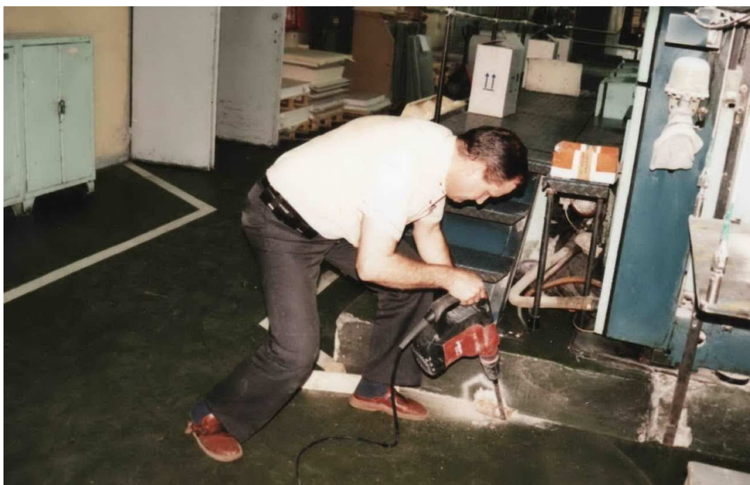
Rys. 2. Wykonywanie odkrywki w stropie nad I kondygnacją na styku z płytą żelbetową na której była ustawiona stara maszyna drukarska PLANETA
