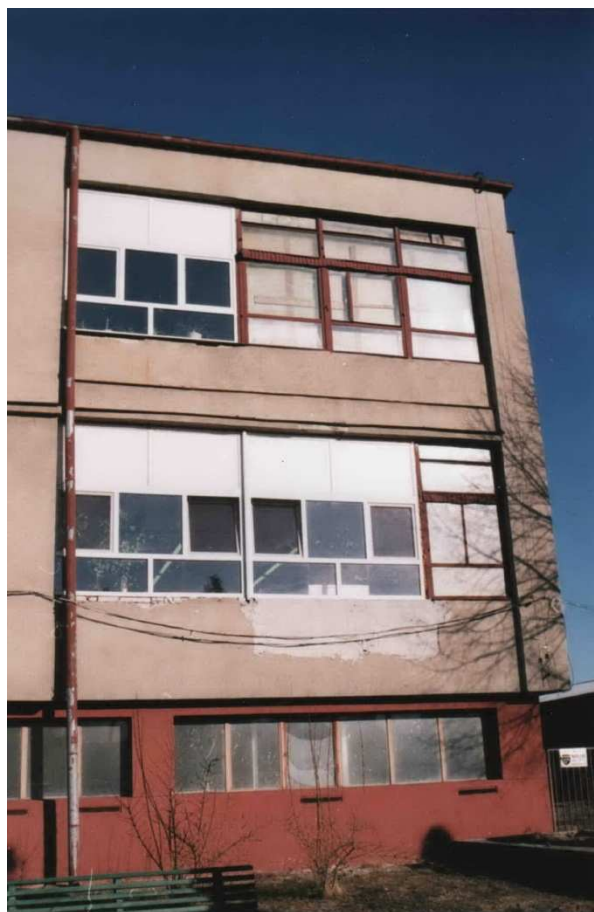
Rys. 1. Ściana szczytowa budynku produkcyjnego, w którym na kondygnacji II planowany był montaż nowej maszyny drukarskiej: a) przed montażem, b) po montażu (transport podzespołów maszyny odbywał się po zdemontowaniu okna i wyburzeniu podokiennej części ściany; – jasny fragment)
