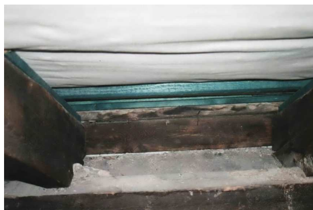
Rys. 4. Widok połaci dachowej z poddasza
