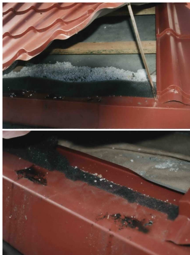
Rys. 2. Fragmenty okapu po częściowym demontażu pokrycia dachowego
