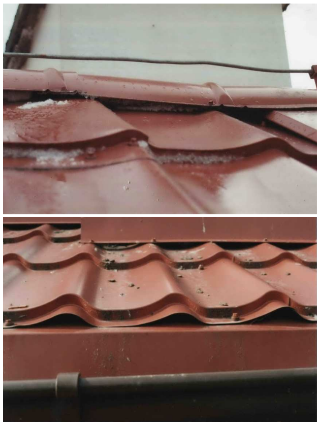
Rys. 1. Wloty przy okapie i wyloty przy kalenicy do przestrzeni wentylacyjnej połaci dachowej
