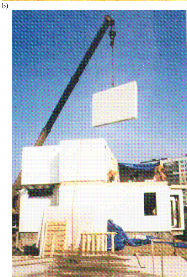
Rys. 8. Montaż budynku z elementów prefabrykowanych bezpośrednio ze środków transportowych
