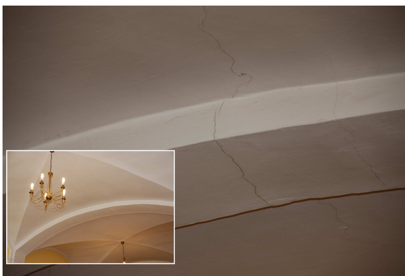
Rys. 4. Identyfikacja zarysowanych łuków i sklepień
