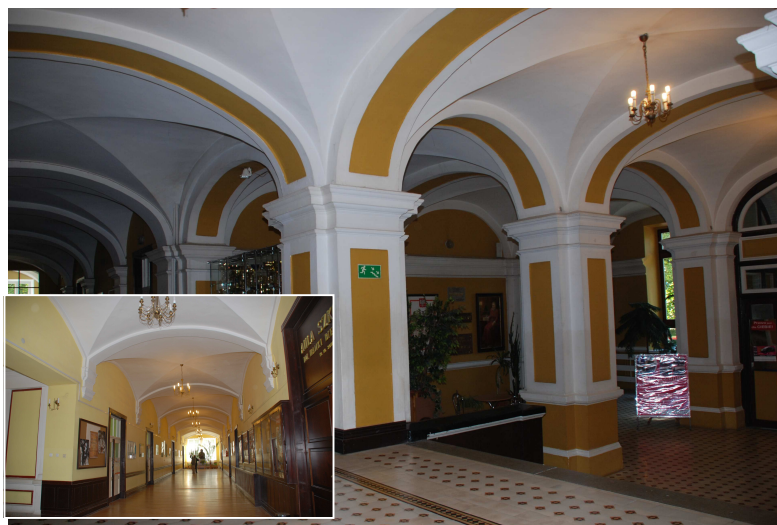
Rys. 3. Krzyżowe sklepienia ceglane nad holem XIX-wiecznego budynku
