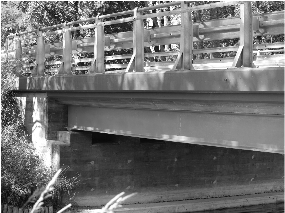
Rys. 6. Most w Jędrzejkach: a) stan przed przebudową – drewniana konstrukcja pomostu oparta na belkach stalowych, b) nowy obiekt – żelbetowa płyta zespolona ze stalowymi dźwigarami
