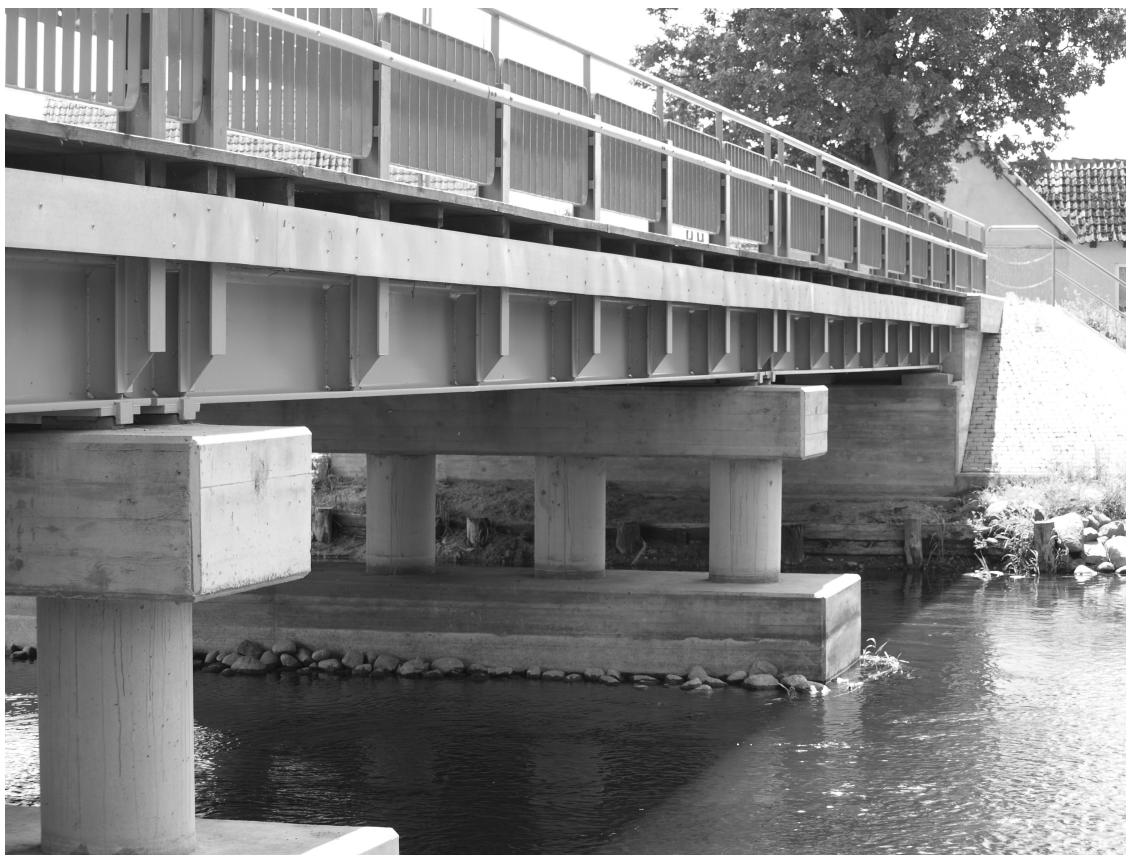
Rys. 1. Most w Lipińskich Małych nad rzeką Elką – zastosowanie pomostu drewnianego opartego na belkach stalowych
