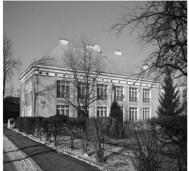
Rys. 1. Widok przedszkola przed termomodernizacją
