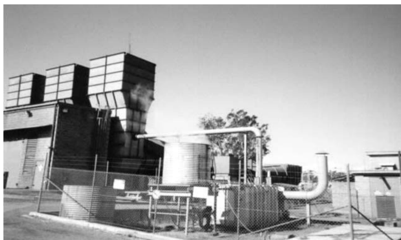
Rys. 5. Druga instalacja Vocsidizera w kopalni Appin
