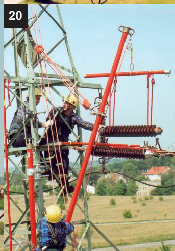
Fot. 19, 20. Wymiana izolatora w zawieszeniu ŁO2-110
