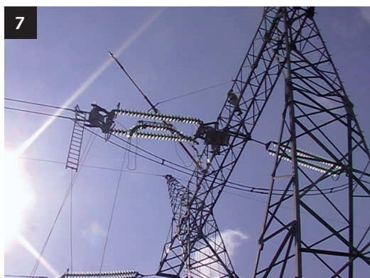
Fot. 7. PPN na linii 400 kV, zawieszenie ŁO2-400 – wciąganie łańcucha izolatorowego
