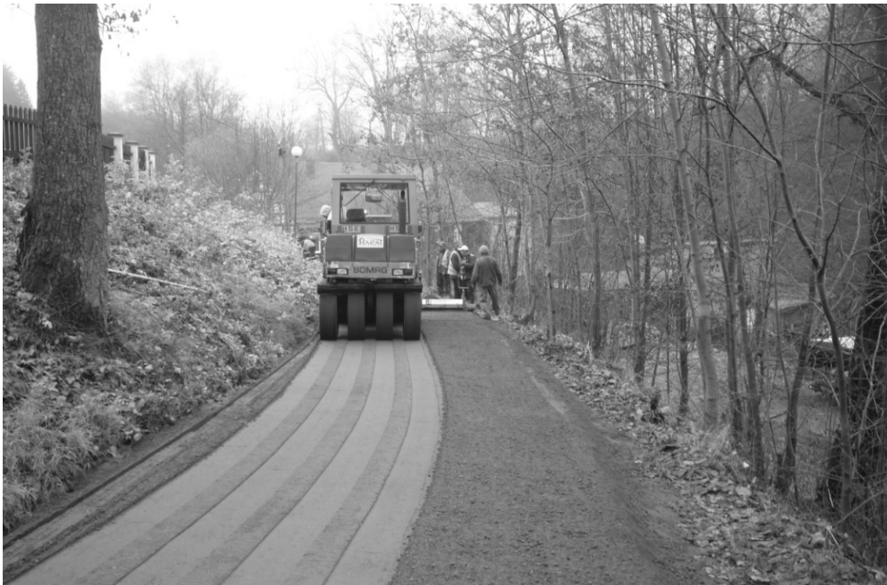
Rys. 3 Zagęszczanie betonu drogowym walcem wibracyjnym (fot. własna)
