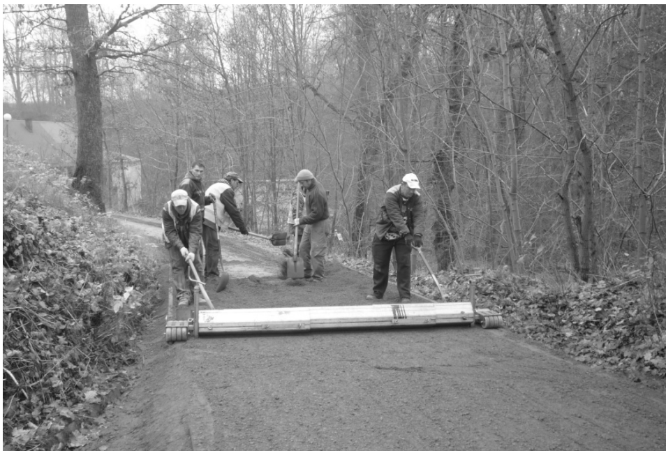
Rys. 2. Profilowanie nawierzchni listwą (fot. własna)
