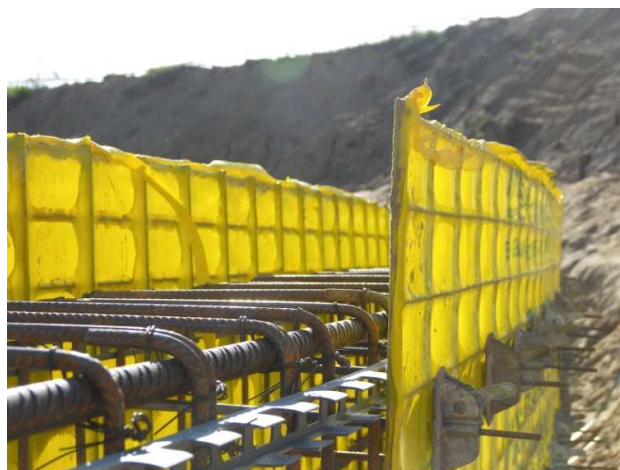
Rys. 3. Wykonanie ściany fundamentowej w deskowaniu traconym „Pecafil” (Dębogórze) ( www.maxfrank.pl )
