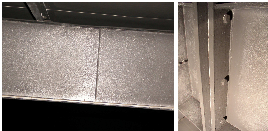
Rys. 6. Przykłady połączeń elementów konstrukcji stalowej hali sportowej
