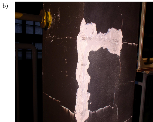
Rys. 5. Efekt działania temperatury pożaru: a) na powierzchni stalowe, b) na elementy murowane
