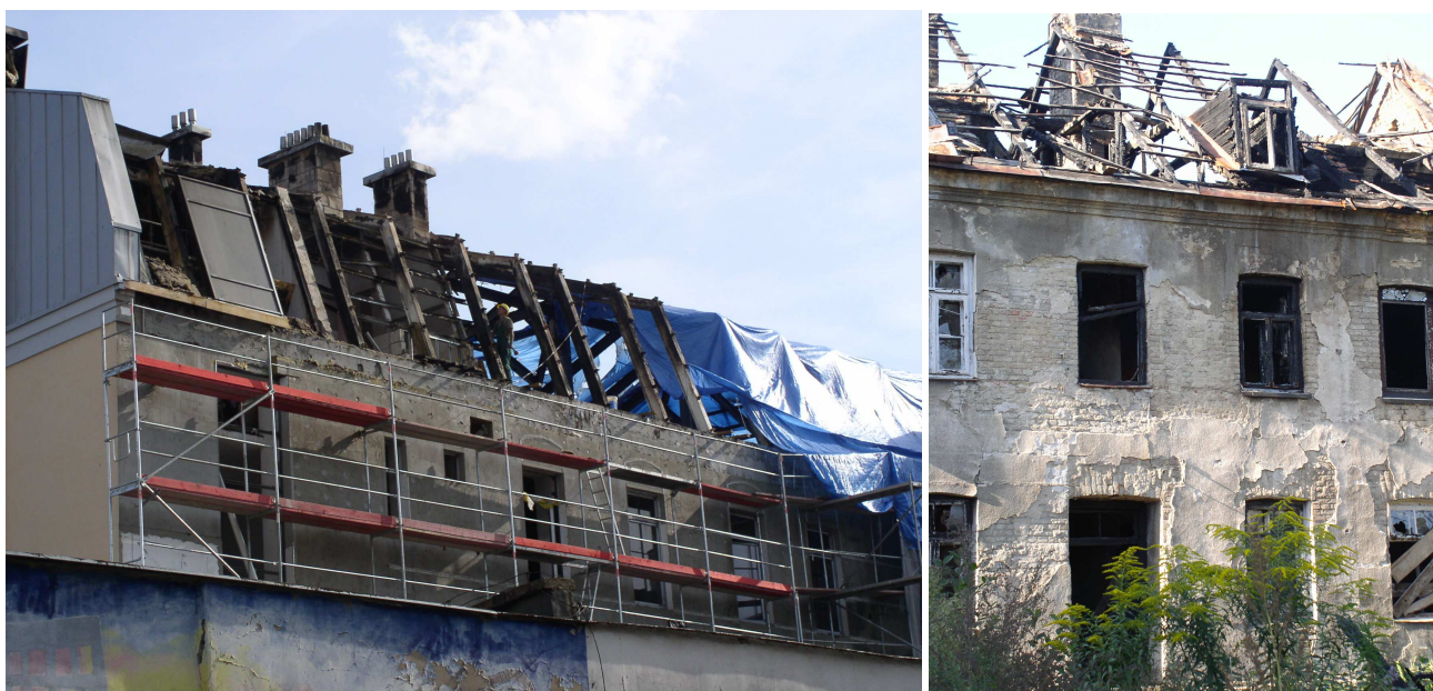
Rys. 1. Efekty działania temperatury pożaru na konstrukcję zabytkowych kamienic
