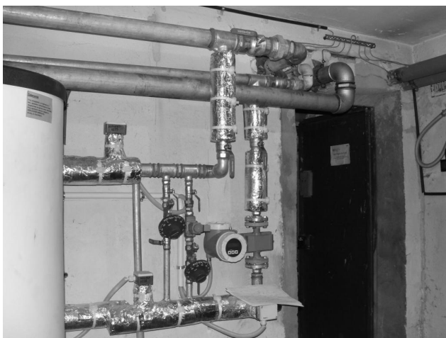
Rys. 2. Układ stabilizacji temperatury i programowego sterowania cyrkulacją
