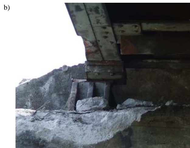
Rys. 1. Uszkodzenia konstrukcji: a) powstałe w wyniku nierównomiernego osiadania (Kwiecień, 2007), b) powstałe w wyniku wykołowania pociągu (Bień, 2009)
