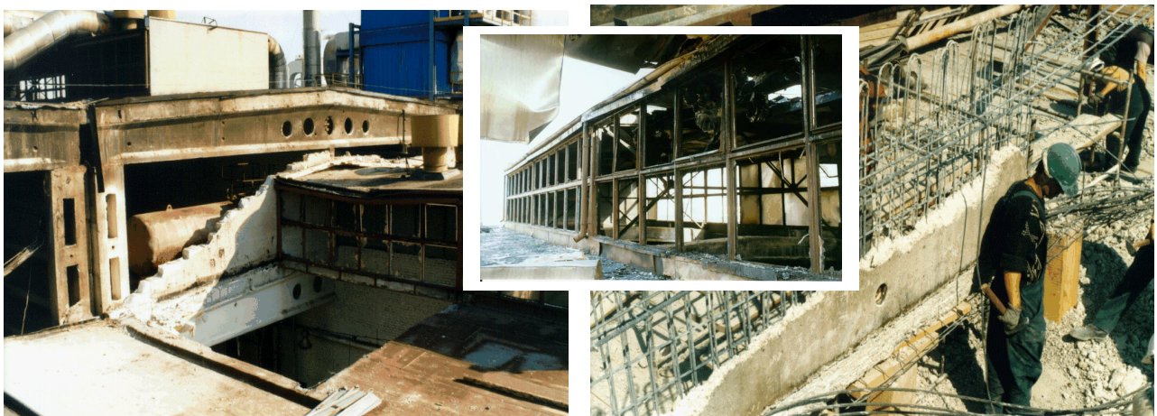
Rys. 1. Efekty działania obciążenia wyjątkowego w postaci wybuchu pyłu drzewnego
