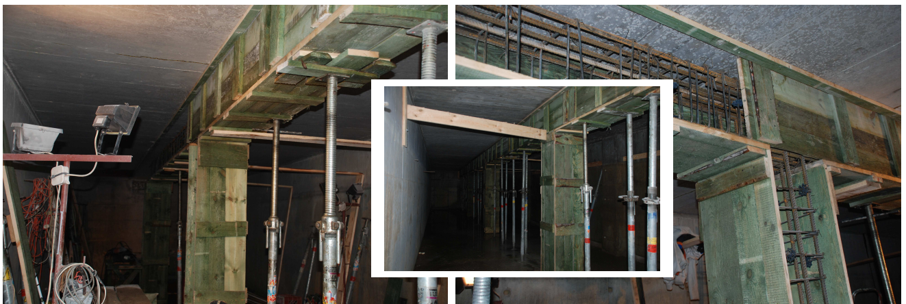
Rys. 10. Realizacja wewnętrznej konstrukcji wzmacniającej płytę zbiornika
