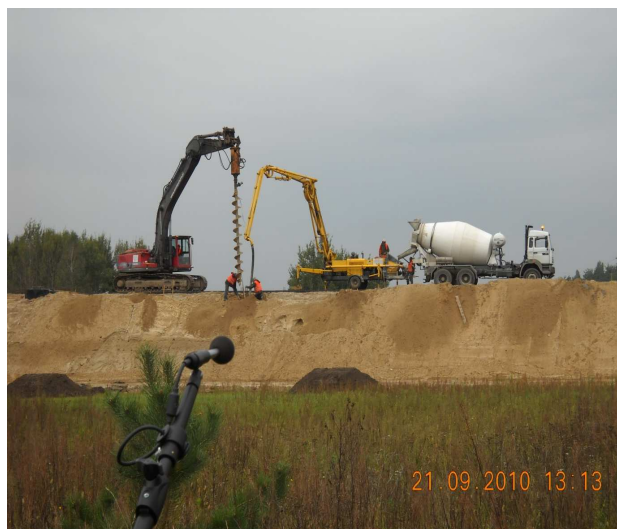
Rys. 8. Pomiary hałasu od robót drogowych (Zakład Inżynierii Drogowej) (fot. M. Motylewicz)
