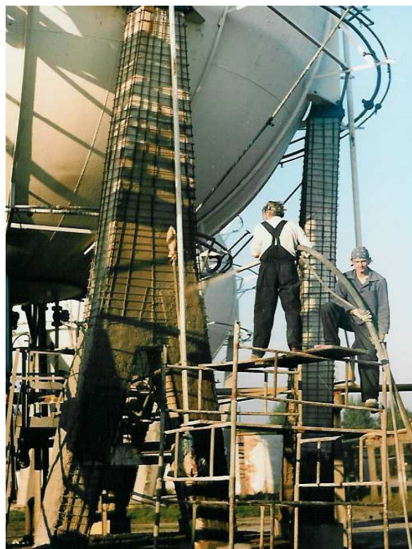
Rys. 6. Badania konstrukcji wsporczych zbiorników kulistych (Katedra Mechaniki Konstrukcji) (fot. J. Krentowski)
