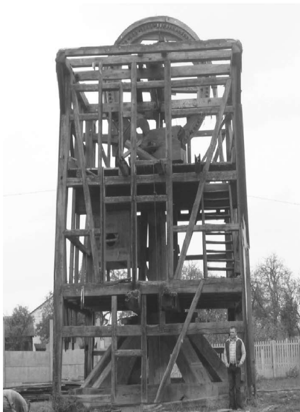
Ryc. 9. Wiatrak z Dębna w trakcie demontażu - widoczna konstrukcja ścian z otworami po drzwiach oraz wewnętrzne urządzenia transmisyjne i robocze wiatraka: u dołu kozioł, wyżej piętro tzw. „mączne” i piętro drugie ze złożeniem kamieni, wałem skrzydłowym i kołem Palecznym. Fot. autorka
