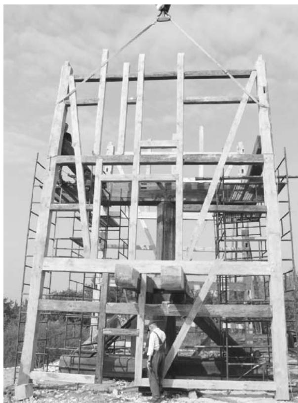
Ryc. 13. Wiatrak z Dębna – montowanie konstrukcji ścian. Fot. autorka
