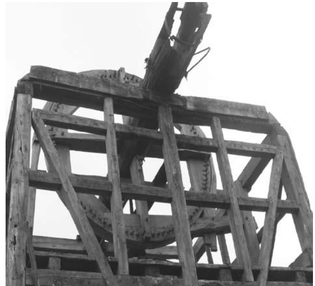
Ryc. 7. Wiatrak z Dębna w trakcie rozbiórki – widoczna konstrukcja ściany, fragment wału skrzydłowego ze zniszczoną głowicą i koło paleczne ze stawidłem. Fot. autorka
