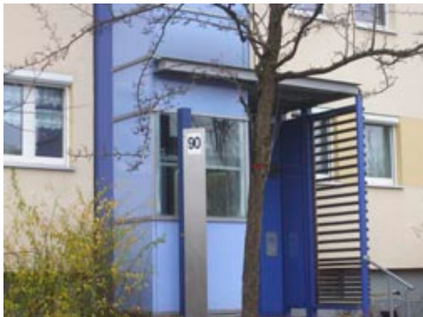
Ryc. 6. Nowo zaprojektowane i wykonane wejście do klatki schodowej budynku przy Stendalerstrasse na osiedlu Hellersdorf w Berlinie. Uwagę zwraca detal architektoniczny projektowany indywidualnie dla każdego budynku, tak by ułatwić mieszkańcom identyfikację z ich blokiem, fot. autor
