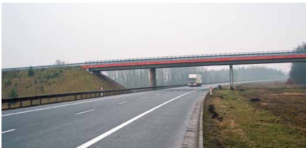
Ryc. 5. Przykład prawidłowego ukształtowania, umocnienia i utrzymania nasypu
