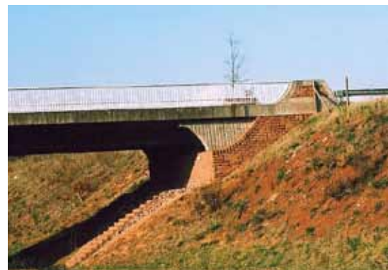
Ryc. 7. Elementy wyposażenia i wykończenia nadające wyglądowi konstrukcji regionalny charakter
