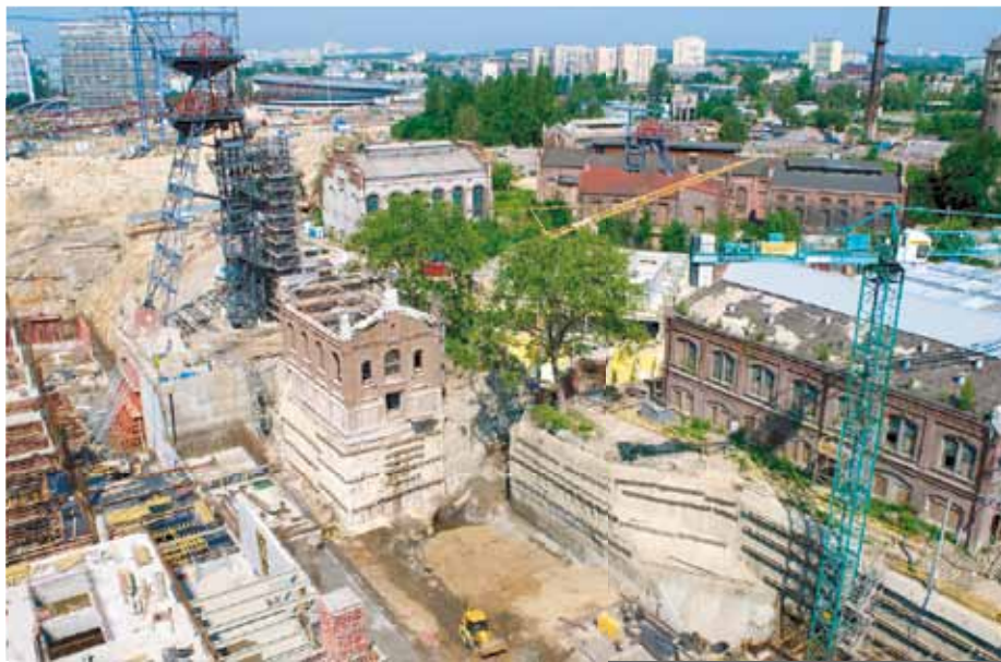
Zabezpieczenie ścian głębokiego wykopu Muzeum Śląskie Katowice
