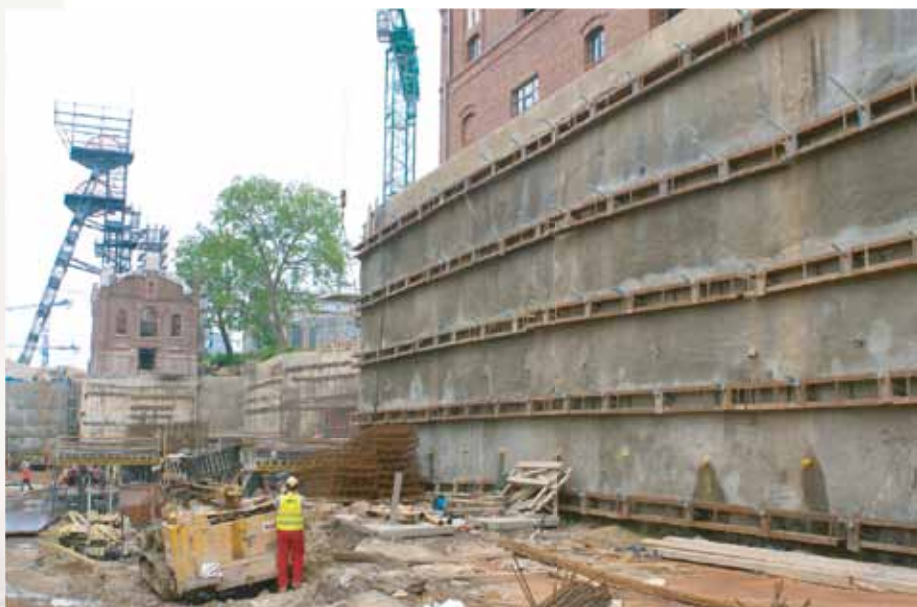
Zabezpieczenie ścian głębokiego wykopu Muzeum Śląskie Katowice
