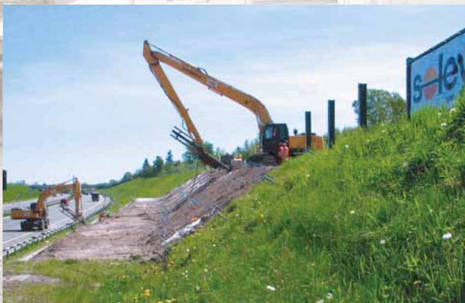
Zabezpieczenie osuwiska - obwodnica A4 Kraków
