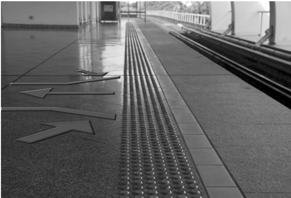
Rys. 10. Prawidłowe położenie dotykowych elementów ostrzegawczych wzdłuż peronu Strona WWW [dostęp 23.05.2012], http://www.electrotypecreative.com/2007/12/the-writings-on-the-floor/
