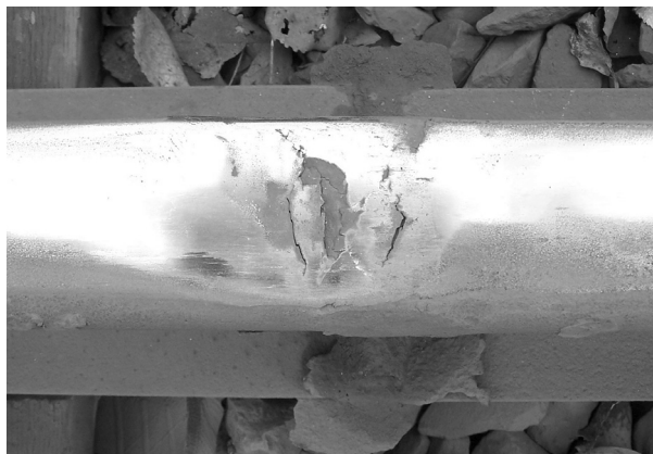
Rys. 8. Zagłębienie na powierzchni tocznej szyny z nadpęknięciami w miejscu spoiny termitowej
