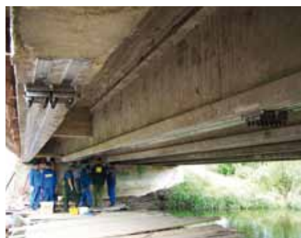
Ryc. 9. Wzmocnienie mostu betonowego wstępnie naprężonymi taśmami CFRP polskim systemem IBDiM
