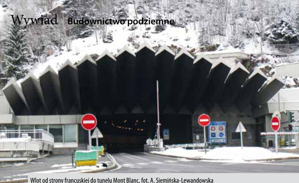
Wlot od strony francuskiej do tunelu Mont Blanc, fot. A. Siemińska-Lewandowska
