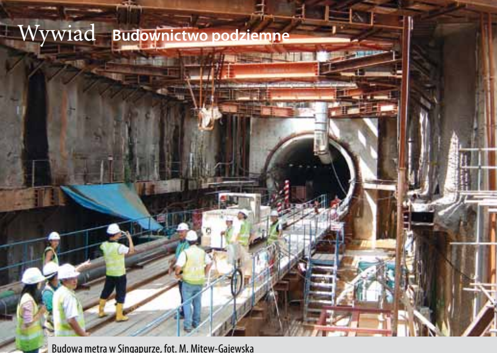
Budowa metra w Singapurze, fot. M. Mitew-Gajewska
