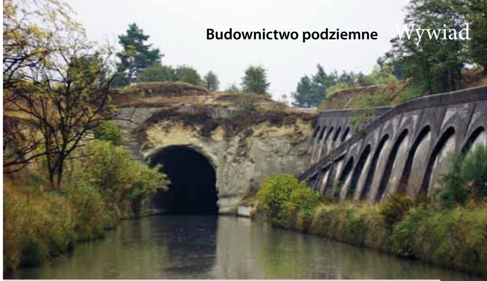
Tunel Malpas – Canal du Midi (Kanał Południowy) na południu Francji, fot. A. Siemińska-Lewandowska
